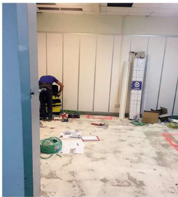
Sono iniziati i lavori alla radiologia del Pronto Soccorso
