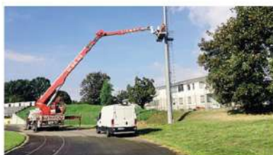
Iniziati i lavori per le nuove luci al centro sportivo
