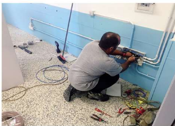
I lavori agli impianti alla "Filippo Turati" di via Pitagora
