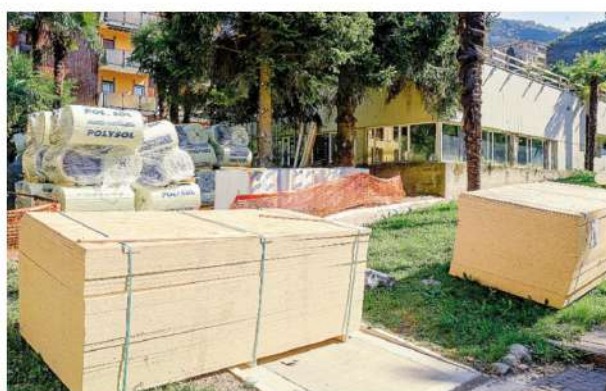
Il cantiere nel cortile della scuola Foscolo, in via Borgovico
