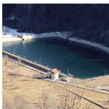
La centrale di Gravedona di proprietà di Acsm-Agam
