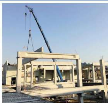
Il cantiere in via Como: in costruzione supermarket del Gruppo Unes
