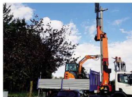
Lavori per l'interramento della linea elettrica a Solbiate
