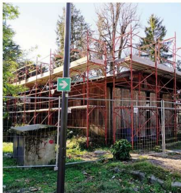
Uno scorcio del cantiere dell'area feste, all'interno del parco di villa Peduzzi
