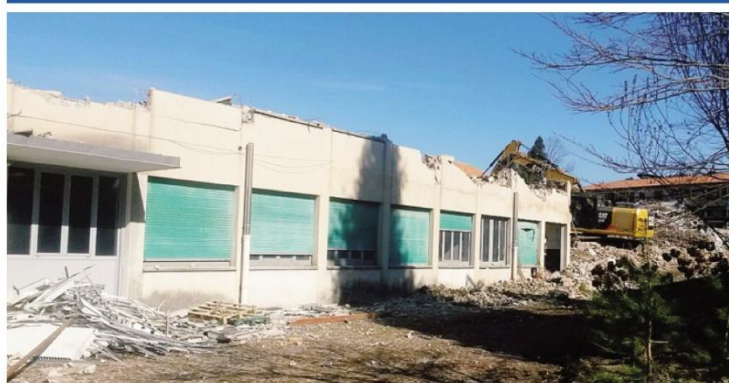
Sono cominciati i lavori per l'abbattimento dei capannoni della ex Soddecor: nella foto una delle ruspe in azione
