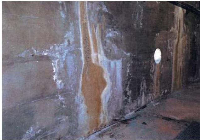
A sinistra, il muro in cemento armato della vasca natatoria, cuore dell'edificio, che presenta uno spessore di 50 centimetri, per un'altezza massima, nel punto più profondo, di un metro e 30 centimetri. Sotto, la rete para calcinacci posizionata al posto della controsoffittatura
