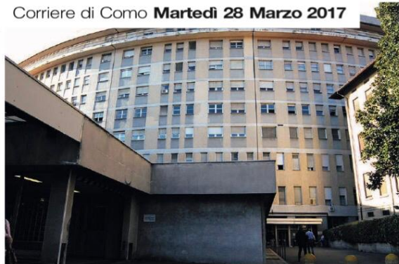
Via Napoleona Il monoblocco del Poliambulatorio dell'Asst Lariana in via Napoleona. Verso le 17 tre dei cinque ascensori erano di nuovo in funzione e i tecnici della ditta incaricata della manutenzione erano ancora all'opera
