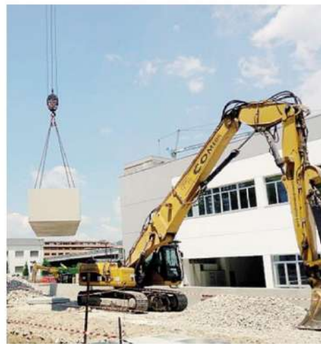
Un cantiere della Comedil Mangino di Olgiate Comasco
