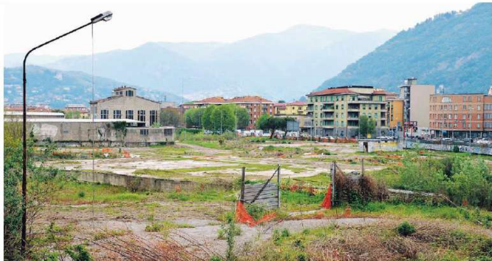
La bonifica infinita nell'area dell'ex Ticosa ha fatto registrare l'ennesimo stop e l'aumento dei costi. Dall'avvio del cantiere servirà oltre un anno di lavori
