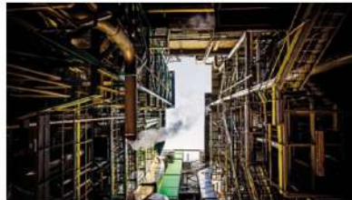
Il termovalorizzatore alle porte di Como
