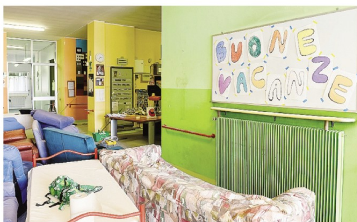
Lavori in corso all'interno del centro diurno di via del Doss a Breccia FOTO BUTTI
