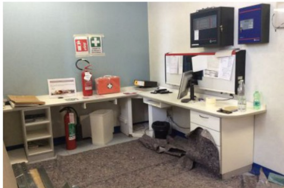
Il cantiere necessario per l'installazione della nuova risonanza magnetica (foto Biliz)
