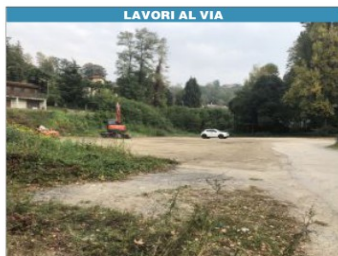
LAVORI AL VIA
