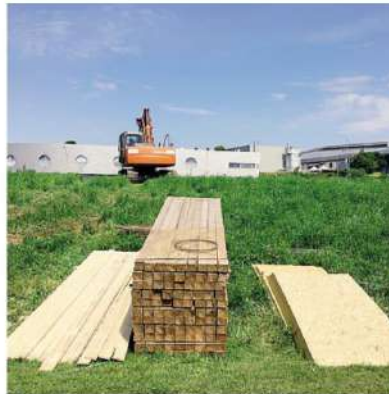
I primi materiali e mezzi nel cantiere di via Milano
