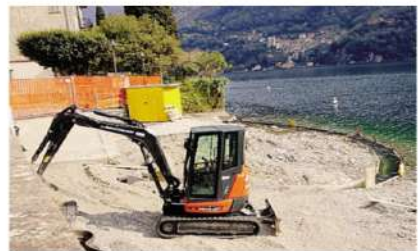
Lavori in corso sulla Riva del Tenciu
