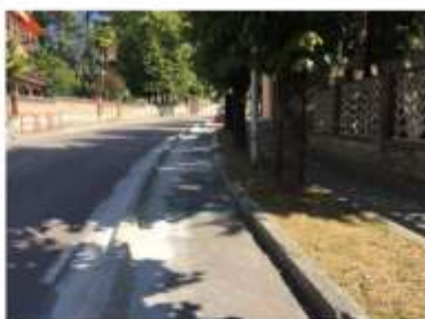
La posa del cordolo che "proteggerà" la nuova pista ciclabile è stata completata su quasi tutta via XXV Aprile, con eliminazione dei posteggi
