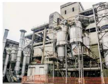
Il cementificio del Gruppo Holcim a Merone
