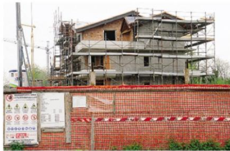
Un cantiere sotto sequestro ARCHIVIO
