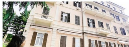
L'edificio de La Quietè Archivio
