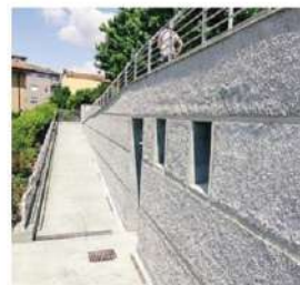
Il muro rifatto nella piazza di Cascina Amata
