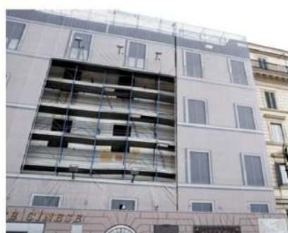
La ristrutturazione della facciata di un palazzo ANSA
