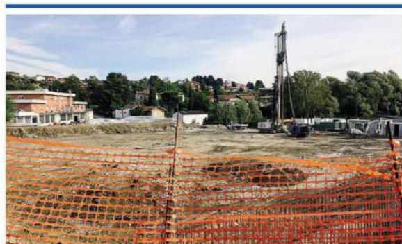
Il cantiere del nuovo Unes in via Como, che aprirà entro febbraio forse con il marchio "Viaggiator Goloso"
