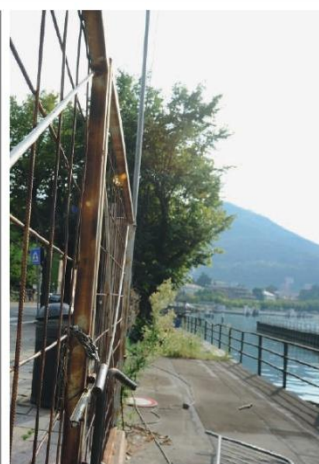
Una parte del cantiere paratie, dove si attende la partenza dei lavori
