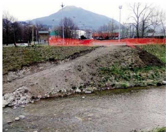
Il cantiere fermo della manutenzione straordinaria del torrente Lambrone
