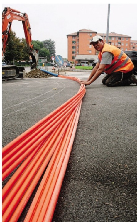
Un cantiere per la posa nel sottosuolo della fibra ottica
