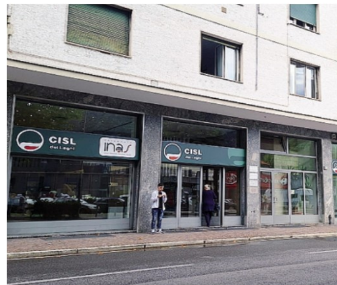
L'ingresso in via Recchi
